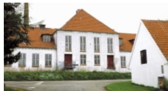
Søndenbro Mejeri udgør et kompleks af bygninger, hvor hovedhusets fremspringende midterparti dominerer anlægget.
