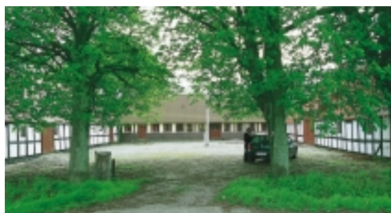
Bækkebovej 3 repræsenterer den noget større udgave af den trelængede gård. Længerne står i bindingsværk, mens stuehuset er opført i grundmur.
