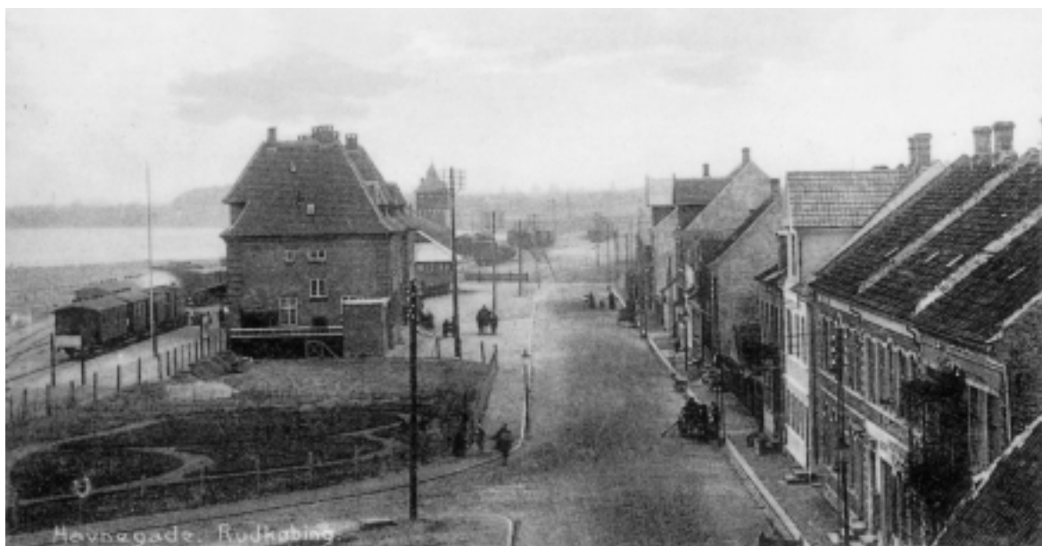
Som Havnegade i Rudkøbing så ud i 1912. Langelandsbanens hovedstation var netop færdigbygget. Byens front langs gadens østside står skarpt optrukket.
