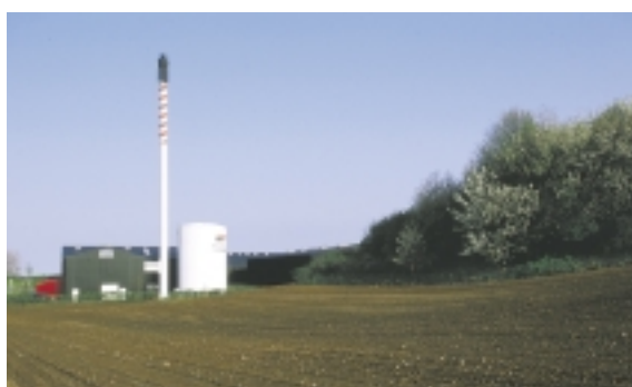
Et moderne forsyningsanlæg som Tryggelev Varmeværk ved Østerskovvej syd for Tryggelev er et godt eksempel på, hvordan et stort moderne industribyggeri med held kan indpasses i et sårbart landskab.
