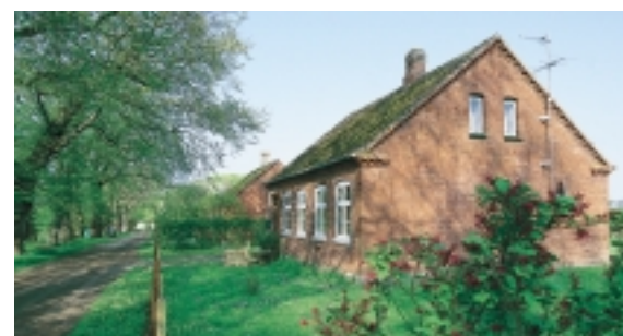
Ved hovedgårdene ses ofte rækker af landarbejderboliger. Husene er nøgterne og i en god håndværksmæssig kvalitet. Her fra Nedergård på Nordlangeland.
