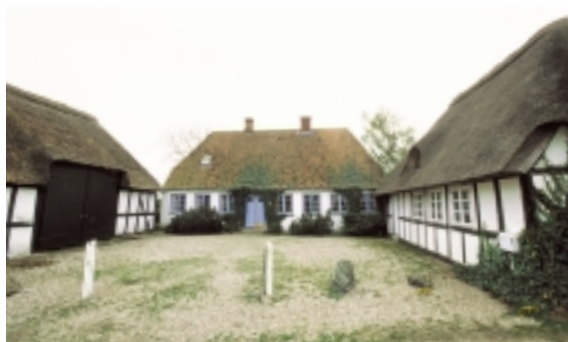
Den trelængede gård på Kragholmvej 33 har udlænger i bindingsværk og strå, mens hovedhuset er opført i mur og tegl.
