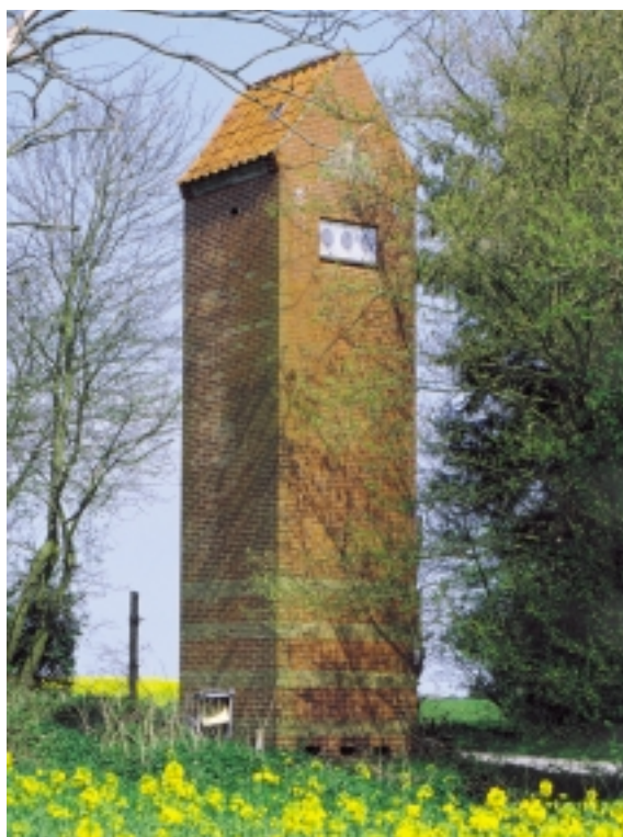
Spredt udover øen ses Langelands Elektricitetsværks transformatorstationer. Her ved Hovvej.
